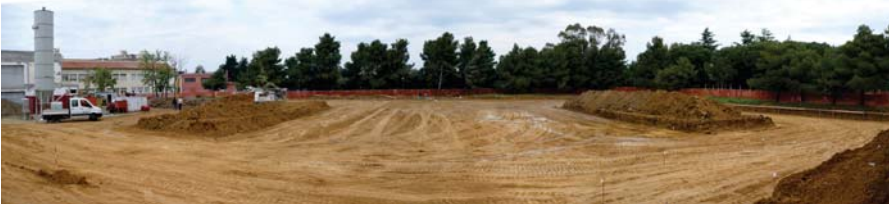
Una foto del cantiere nelle fasi di scavo
